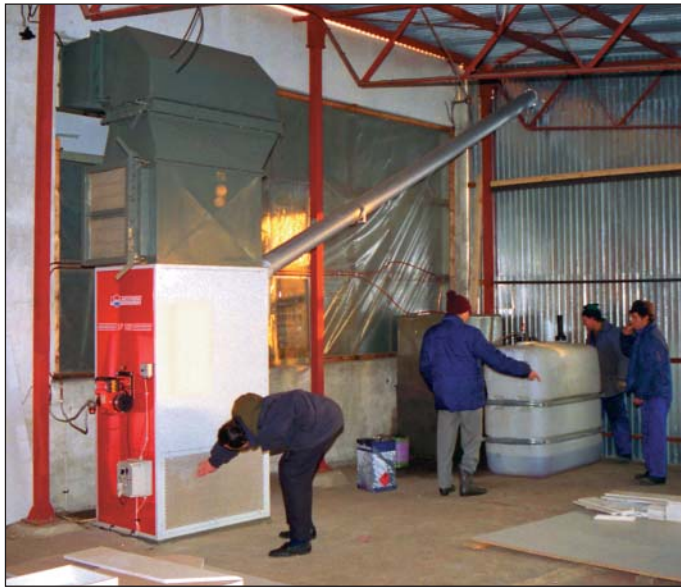
Fot. 3 Montaż systemu centralnego ogrzewania powietrznego w hali przemysłowej
