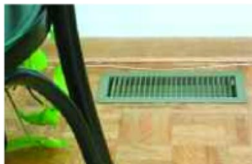
Dwa zdjęcia po lewej: kratki nadmuchiowe – estetyczne, niemal niewidoczne elementy doprowadzające ciepło do pomieszczenia. Kratki można umieszczać w podłodze, na suficie lub na ścianach
