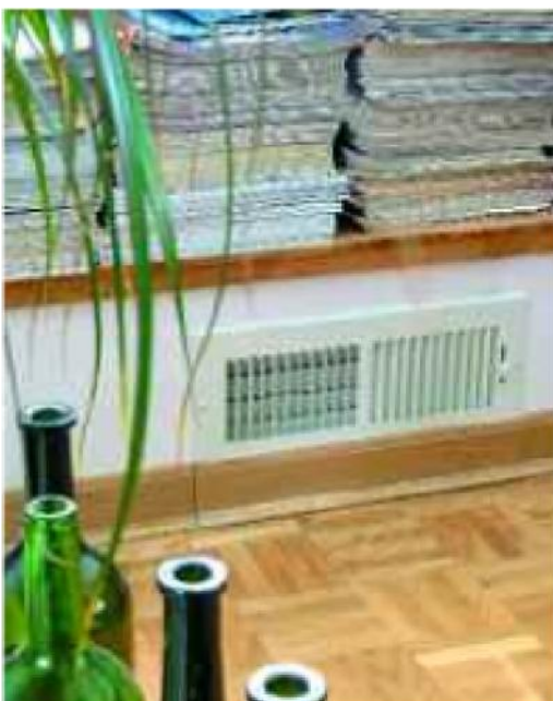
Przewody ogrzewania powietrznego. Najlepiej montować je podczas wznoszenia domu – w gotowych budynkach trzeba je maskować sufitem podwieszanym
