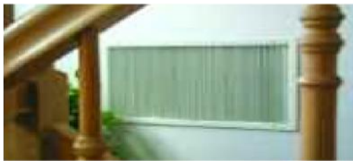
Czerpnia wewn trzna. Urz dzenie to nale y umie ci w centralnej cz ci domu
